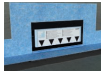
Install Geberit sealing foil
