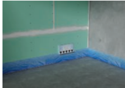
Lay edge insulation strip
